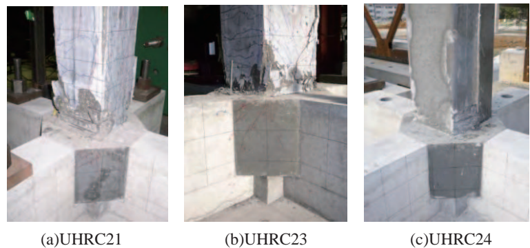
写真-3 接合部状況
