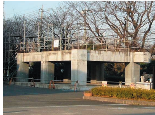
写真-1 構造体の外観①
