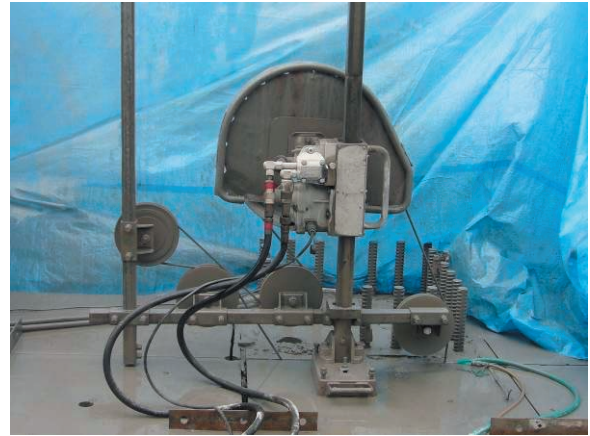
写真-5 梁切断状況
