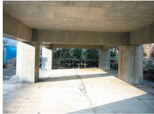
写真-2 構造体の外観②
