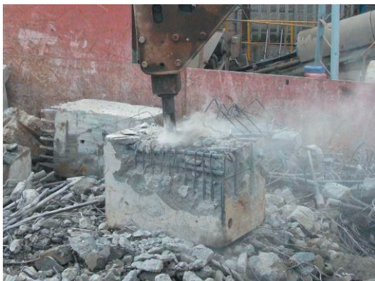
写真-9 柱破砕状況 (ジャイアントブレイカ)
