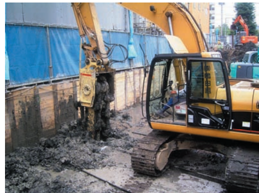
写真-1 トレンチャー施工状況(山留め周辺)
