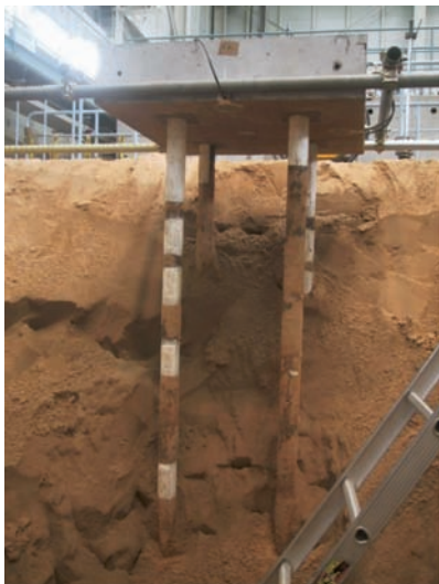
写真-2 ラフトおよび杭
