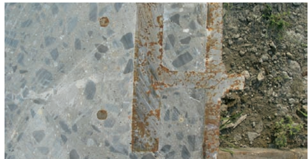
写真-1 ダイアフラム部の充填状況(A柱)
