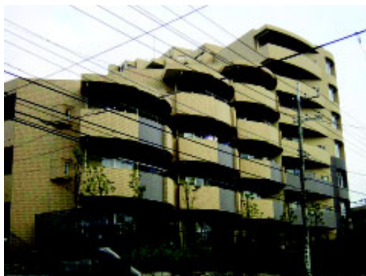
写真-1 建物外観
