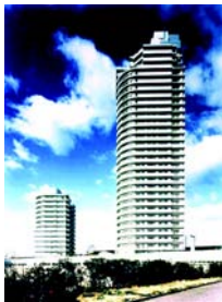
タワー-瀬戸大橋
