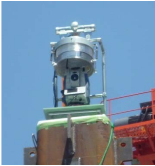
写真1 自動追尾トータルステーション
