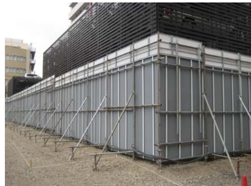
写真2 建設現場適用状況
