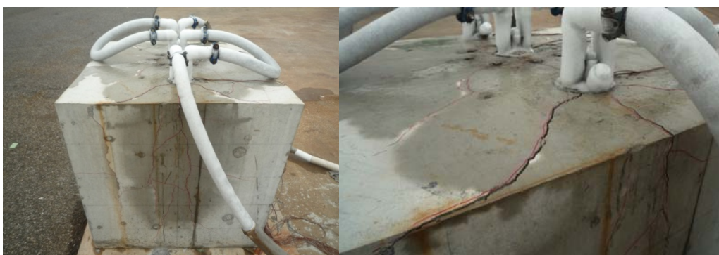
写真-1 実験での破壊状況
