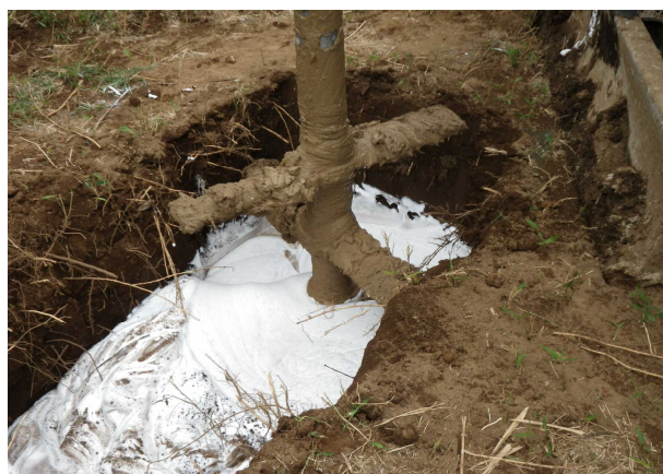
写真 2 気泡掘削攪拌開始時
