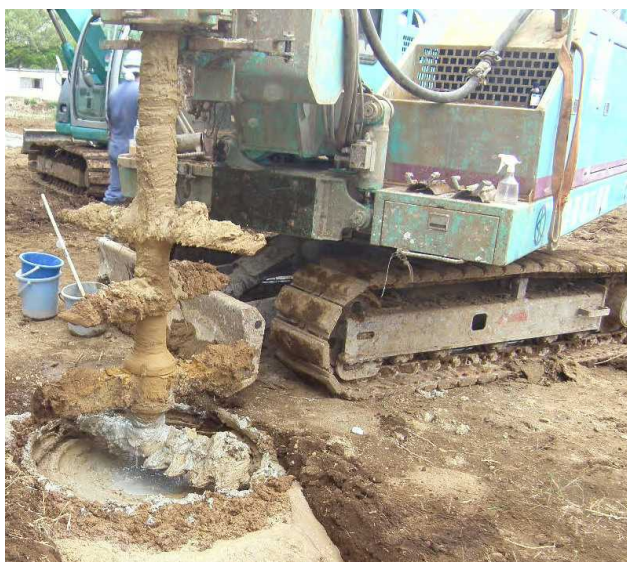
写真 3 杭施工完了時
