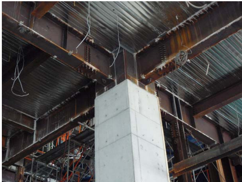
柱梁接合部(タイプⅡ)の施工写真
