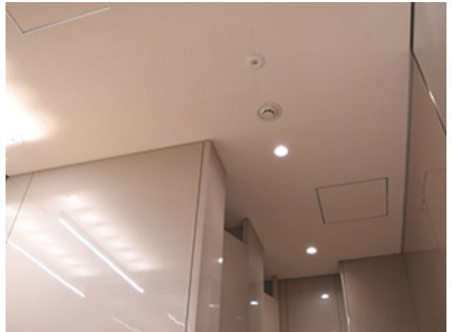
トイレ天井への施工例
