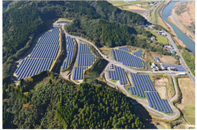
宮崎国富メガソーラー発電所（4.2MW）
