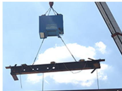
吊り荷旋回制御装置の現場適用状況
