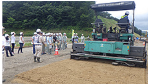
工事説明の様子
