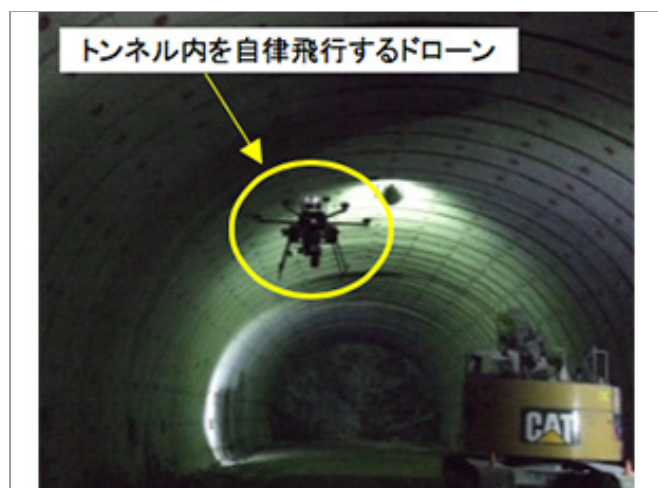
図.2 トンネル内を自律飛行するドローン
