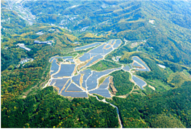
長崎田手原メガソーラー発電所（13.2MW）
