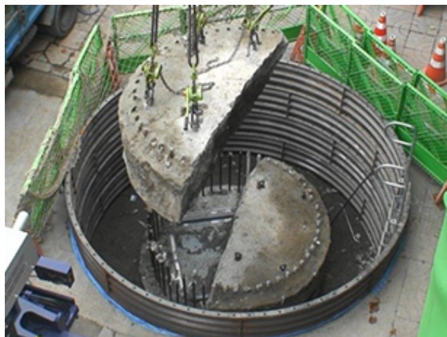
余盛コンクリートの撤去状況
