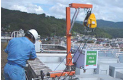
福島県内のビル屋上で測定ロボットシステムをセット（全パーツを工具レスで組立）
