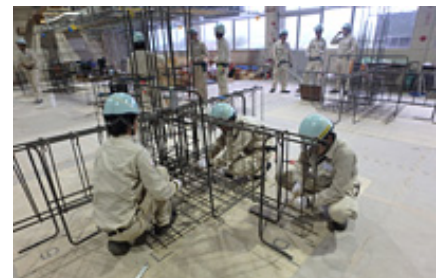
構造鉄筋の組み立て作業の様子
