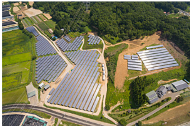
福島県川俣町山木屋地区復興メガソーラー発電所 （2.2MW）
