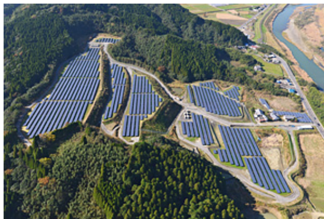
宮崎国富メガソーラー発電所（4.2MW）
