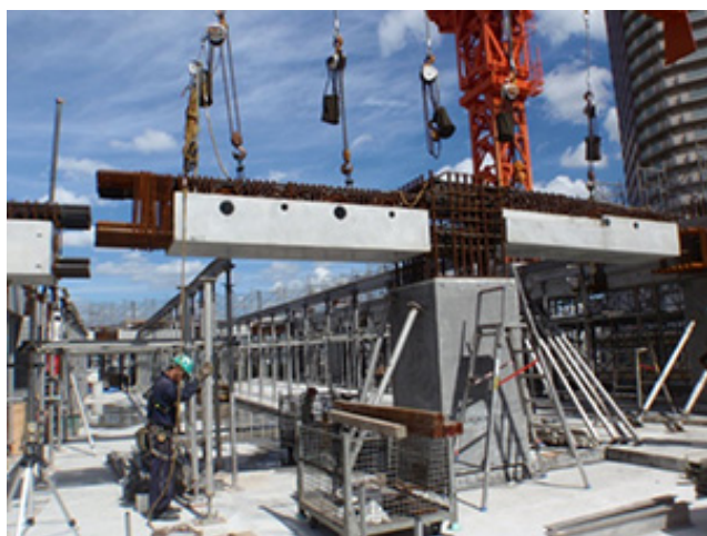
プレキャスト鉄筋コンクリート梁の施工状況
