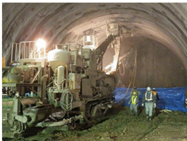
低リバウンド吹付けコンクリートの施工状況
