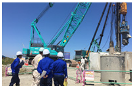
モデル工事の監査状況
