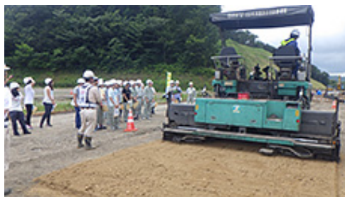
工事説明の様子
