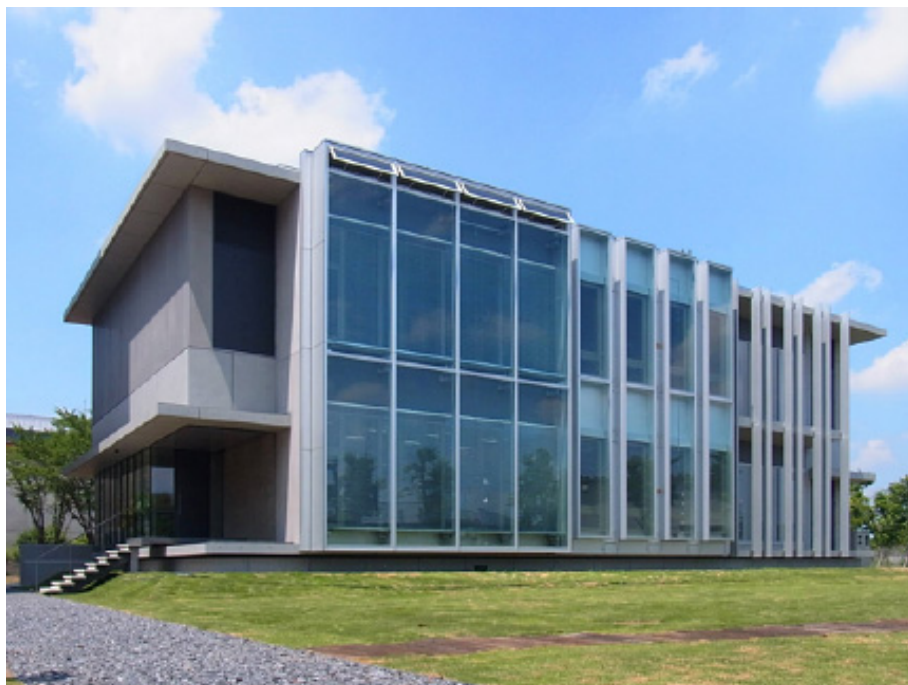
環境技術実証棟
