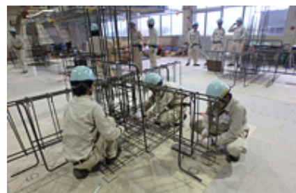
構造鉄筋の組み立て作業の様子
