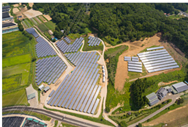
福島県川俣町山木屋地区復興メガソーラー発電所 （2.2MW）
