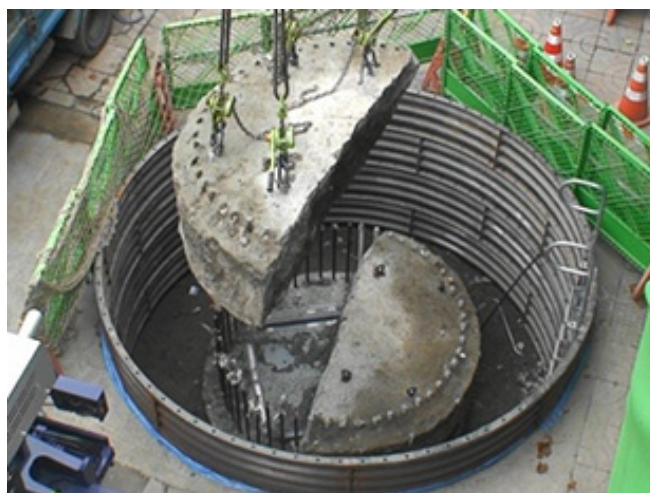
余盛コンクリートの撤去状況
