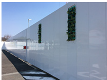
仮囲いの壁面緑化
