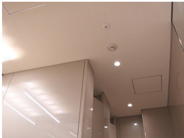
トイレ天井への施工例
