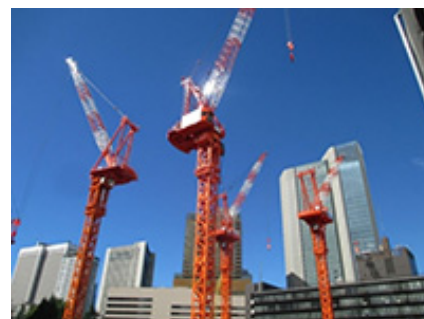
現場に設置されたタワークレーン
