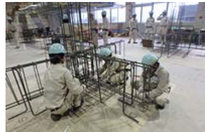
構造鉄筋の組み立て作業の様子
