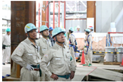
作業場内での点検の様子
