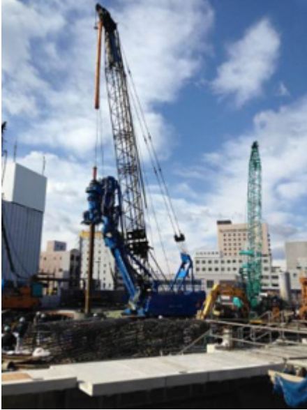
大垣駅南街区第一種市街地再開発事業での施工状況
