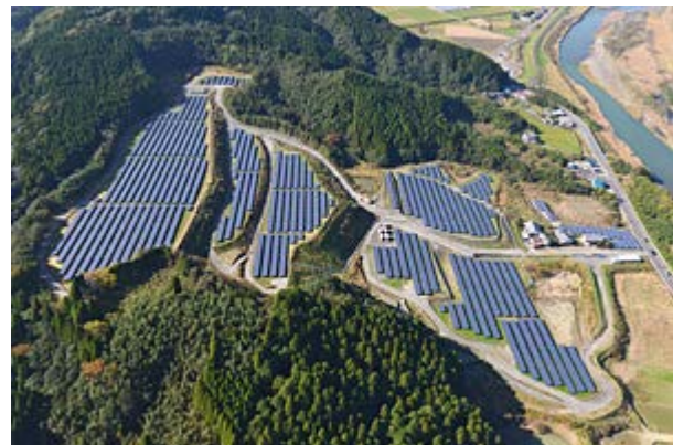
宮崎国富メガソーラー発電所（4.2MW）
