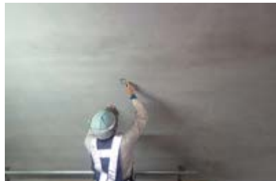
覆工コンクリート調査状況
