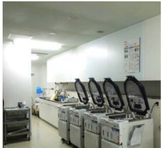
オドキャッチャーを塗装した天井 (内視鏡洗浄室)
