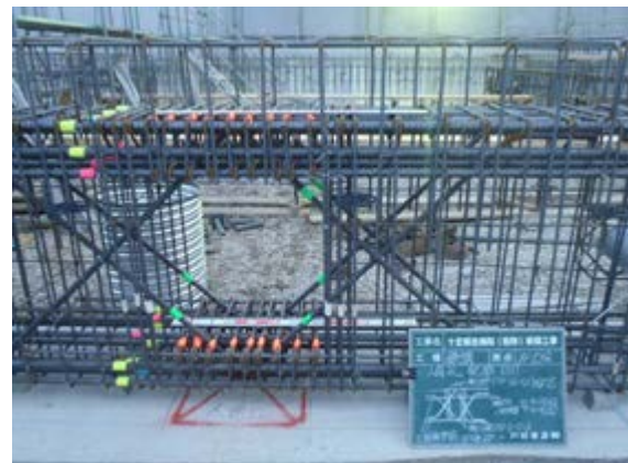
補強配筋状況
