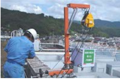
福島県内のビル屋上で測定ロボットシステムをセット（全パーツを工具レスで組立）
