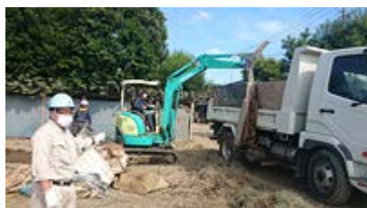
がれき撤去の様子
