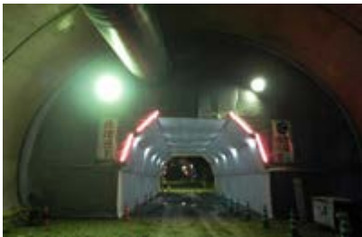
覆工コンクリート施工状況
