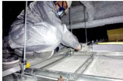
天井内施工状況
