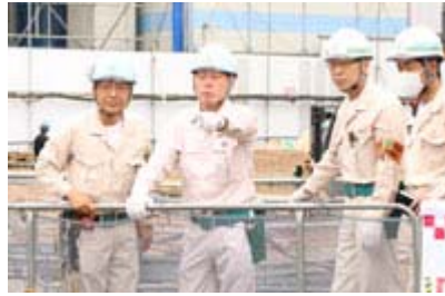
作業場内の点検の様子
