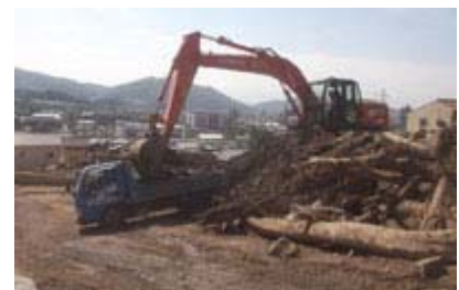
土砂運搬の様子
