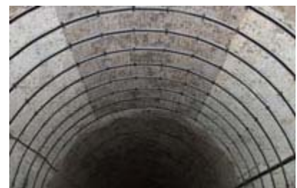
バサルト繊維メッシュ(中央)とバサルト繊維プレートを設置したトンネル内面
