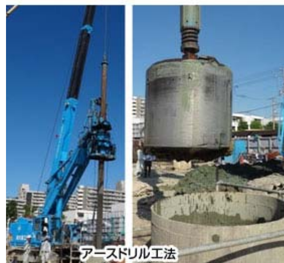
場所打ち杭工事への適用状況
