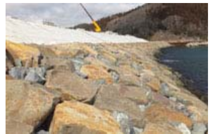
自然石を採用した防潮堤の基礎部
