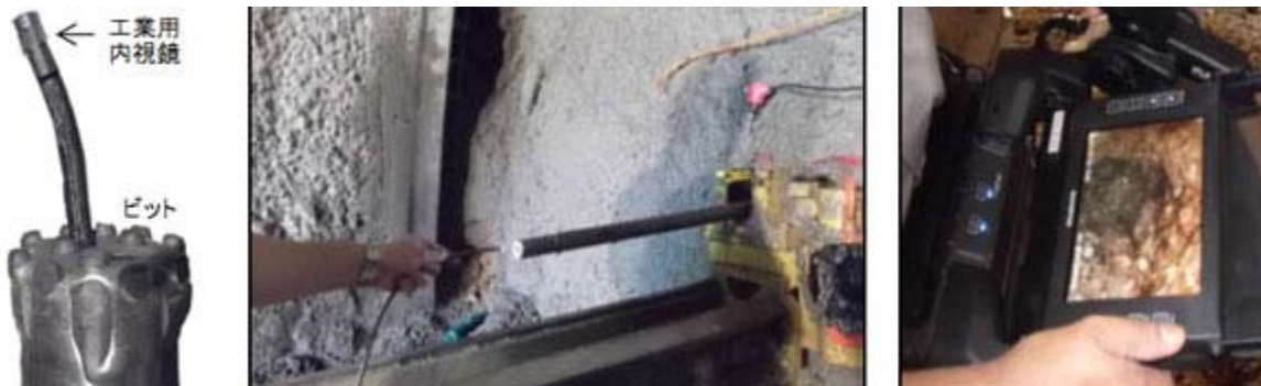
DRiスコープによる切羽前方地山の調査状況
