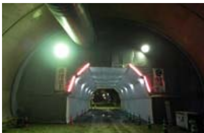
覆工コンクリート施工状況
