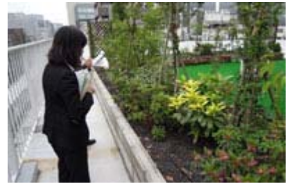
屋上調査状況の様子
