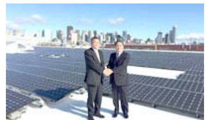
設置完了時の様子
