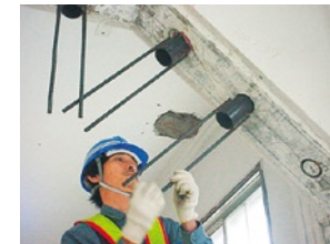
鋼管コッター取り付け状況
