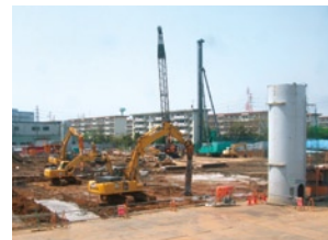
施工状況 （NTTロジスコ千葉物流センターD棟）
