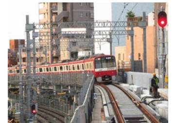
高架化された線路（上り線）
