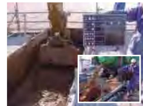
混合攪拌状況と余剰汚泥投入状況
