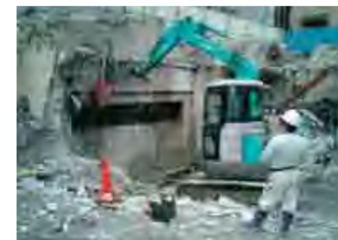
NEO カッター工法による解体作業状況
