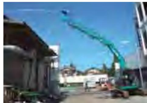
散水ロボットの使用による粉じん飛散防止対策
