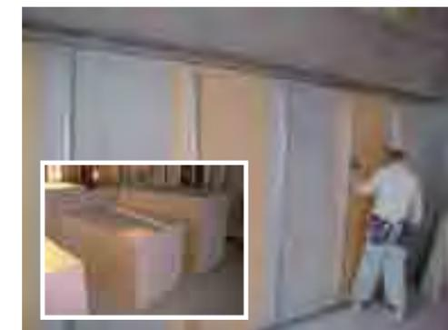
プレカット搬入された石膏ボードと施工状況
