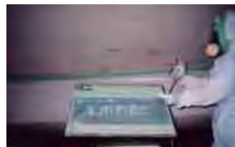
飛散抑制溶液を吹付け
