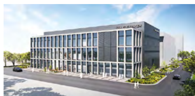
筑波技術研究所(仮称)構造材料棟
