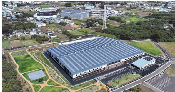
所沢市第2一般廃棄物最終処分場
