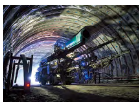
トンネル穿孔機械(ドリルジャンボ)
