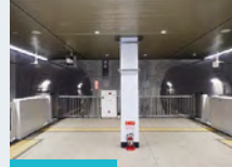
2023 相鉄・東急直通線 綱島トンネル
