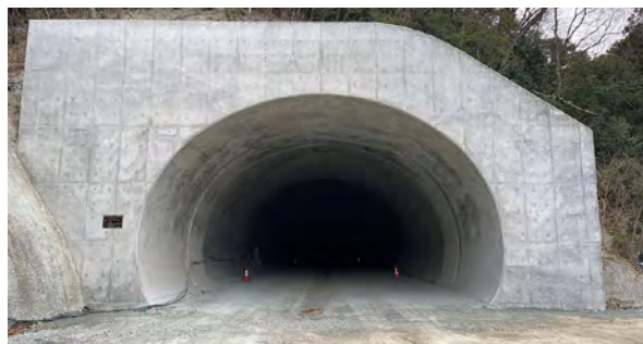
四国地震整備津山トンネル
