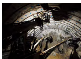
鏡ボルト打設状況
