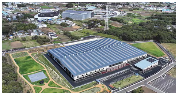
所沢市第2一般廃棄物最終処分場
