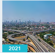
2021 ケラニ河新橋建設工事
