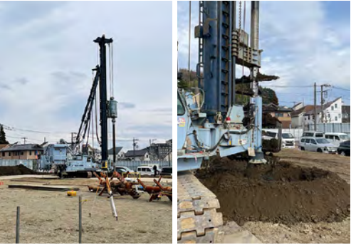
RD40を使用した杭打設重機 (協力:株式会社テクノックス)
