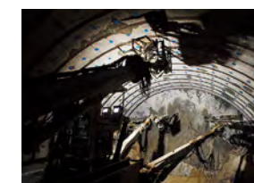
鏡ボルト打設状況
