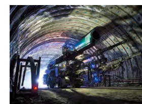
トンネル穿孔機械(ドリルジャンボ)
