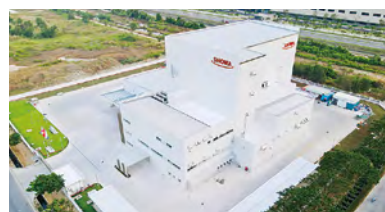
Showa Sangyo International Vietnam New Factory 【ベトナム】
