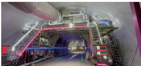
覆工コンクリートの自動打設ロボット「セントルフェューチャーズ®」
