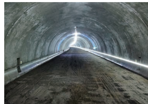
窪川佐賀道路平串トンネル
