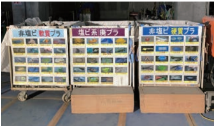
廃プラ分別ヤード
