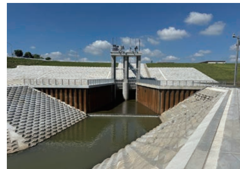
関東地整入間川古谷橋管改築工事
