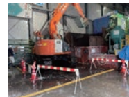
シールド立坑での掘削作業
