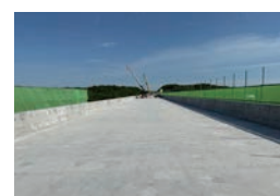
床版取替工事後のママチ川橋
