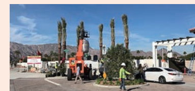
植栽工事施工の様子
