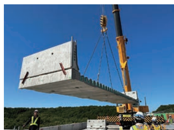
床版と壁高欄の一体架設
