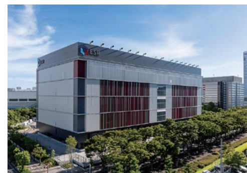
ESR 南港 OS1 データセンター
