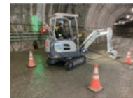
坑口での路盤維持作業
