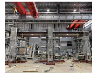
PCaラーメン構造の実大施工実験
