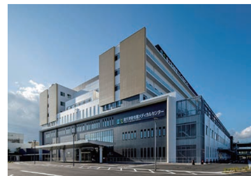
泉大津急性期メディカルセンター
