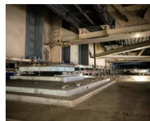
新設支承設置状況
