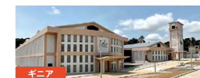
ギニア Projet de Construction de l'Institut National de Santé Publique en République de Guinée 構造:RC造 規模:(ラボ/研修等)地上2階(事務棟)地上1階 延床:4,083.24m 2 用途:研究、検査および研修施設
