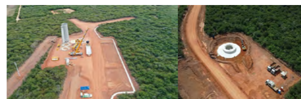
ブラジル風力発電2期工事(2024年12月稼働予定)
