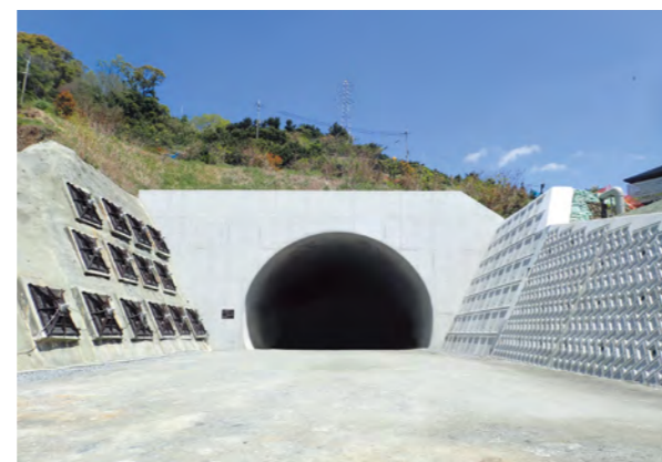
有田海南道路5号トンネル工事
