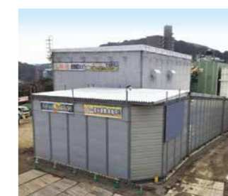
防音ハウス全景
