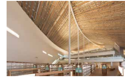
ミライオン図書館、大村市歴史資料館建設工事 長崎県大村市
