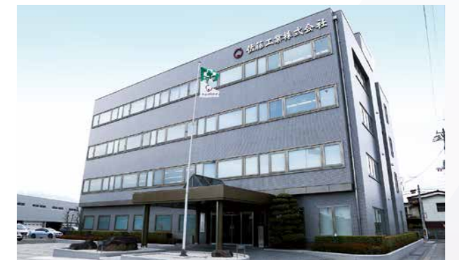
佐藤工業株式会社 本社社屋(福島県福島市)
