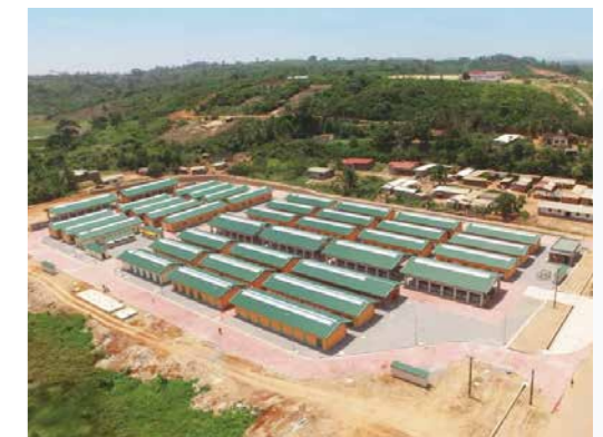
新設された中央市場全景
