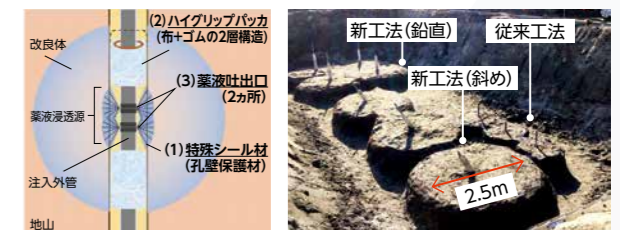
ハイグリップグラウト工法の特長 フィールド実証試験での改良体の確認
