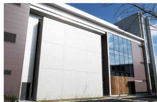
構造・施工実験棟(2019年11月竣工予定)
