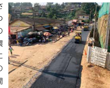
水揚げ場周辺の道路整備
