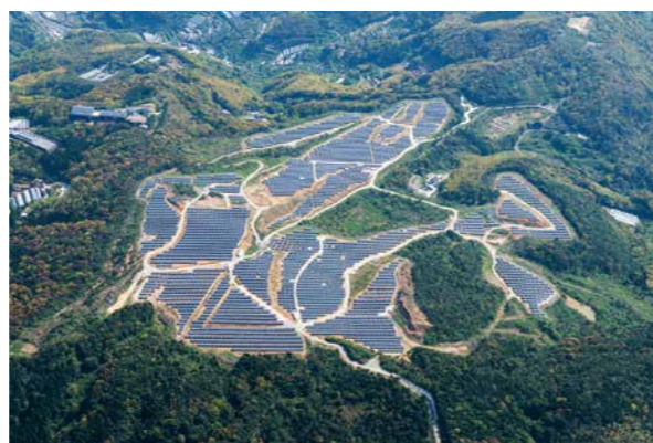
長崎県手原メガソーラー発電所
