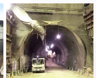
防音ハウス内のトンネル掘削状況
