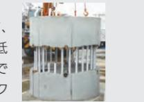
4 凍結圧力による杭頭処理
