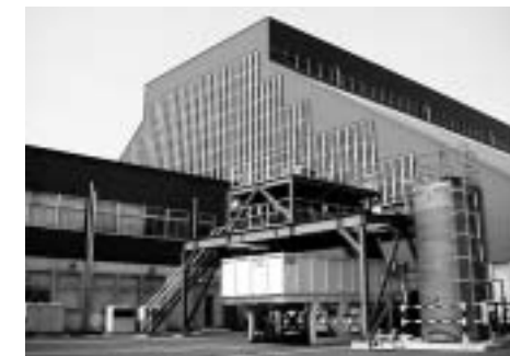
ガス化溶融炉施設
