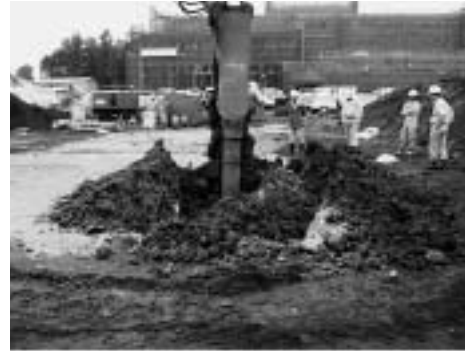
地盤改良工法 SLPの施工実験
