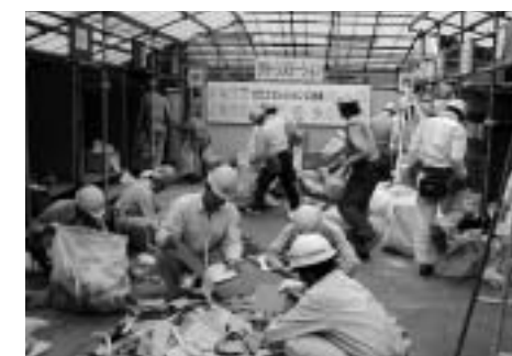
作業員全員による一斉分別収集作業
