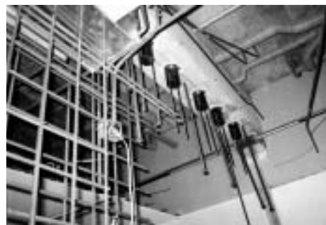
鋼管コッター工法の施工状況
