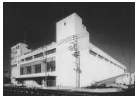
浮き基礎方式に変更した建物
