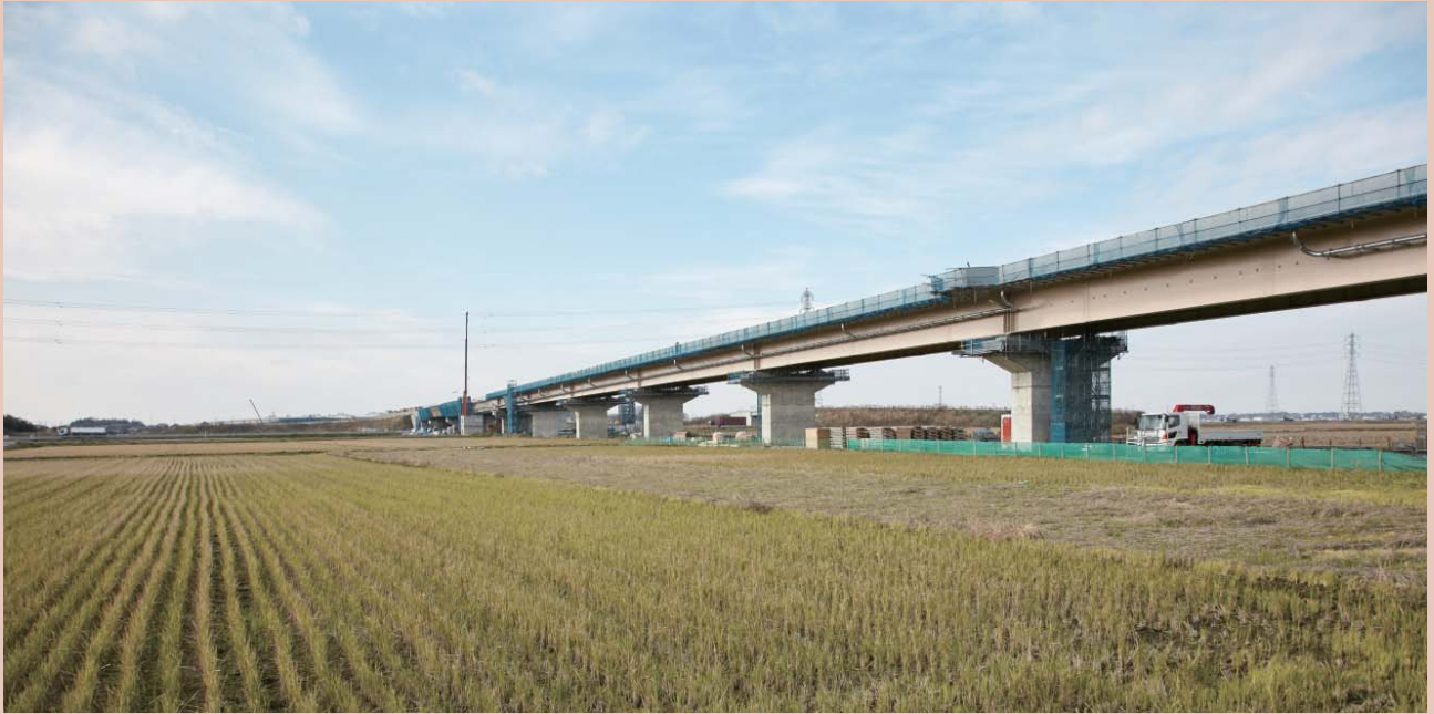
整備が進む常総ICと周辺の農地
