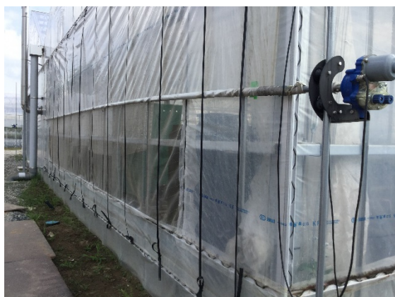
写真-2 側窓（巻き上げ式）
