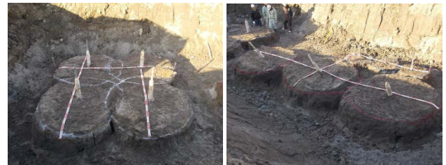
写真-5 改良体発掘写真(左:改良A, 右:改良B)
