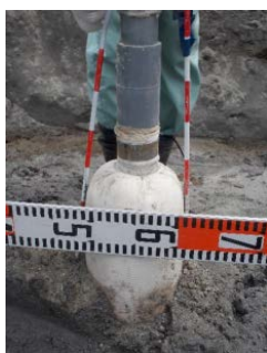
写真-6 地山パッカ発掘状況
