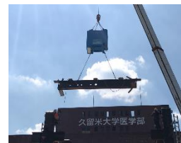
写真-17 吊荷旋回制御装置使用状況
