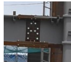
写真-18 仮ボルト不要接合治具使用状況
