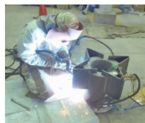
(角型プレート溶接状況)
