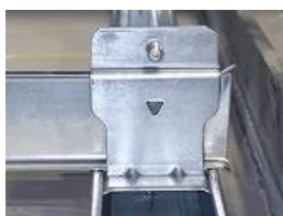
写真-4 耐風圧クリップ
