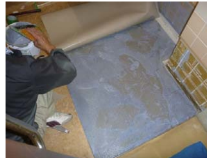
写真-9 長尺シート施工
