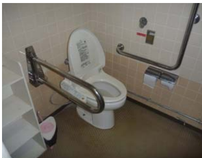
写真-7 改修前のトイレ
