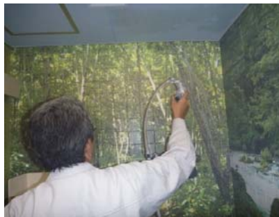
写真-11 光触媒コーティング剤施工
