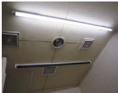
写真-8 照明の取り付け
