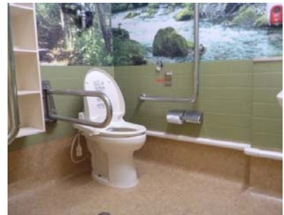
写真-12 改修後のトイレ
