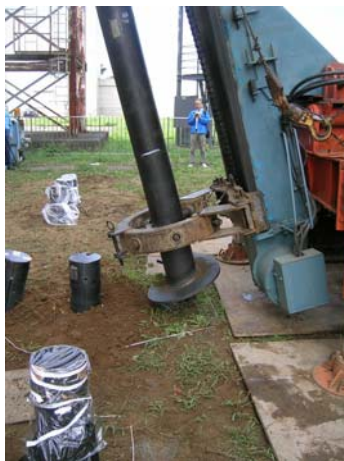
写真-2 試験杭の打設
