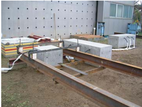
写真-1 原位置水平載荷試験の状況
