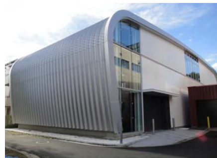
写真-5 曲面屋根の外部建屋
