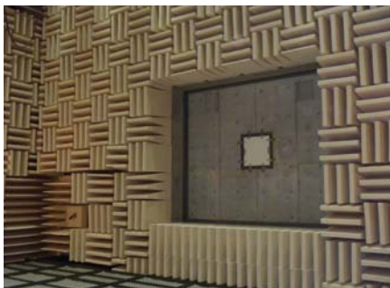
写真-2 無響室側の開口 (GW 取り外し後)
