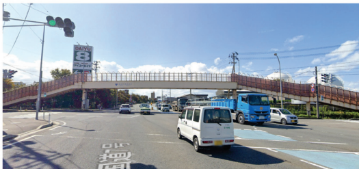
写真5 シミュレーション箇所 歩道橋状況
