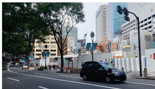
写真3 搬入エリア状況
