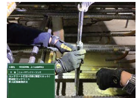
写真 3 N 式貫入試験の実施
