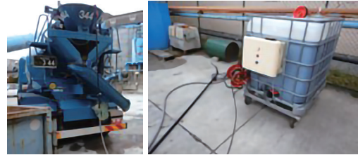
写真 1 超遅延剤添加状況
