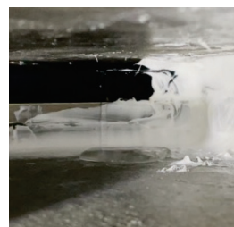
写真10 Lゴム端部の漏水
