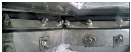
写真A8 試験体④Cの漏水状況
