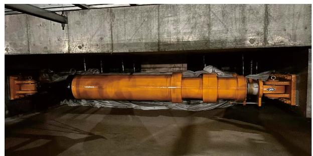
写真2 自己復元型トリガー機構付きオイルダンパー
