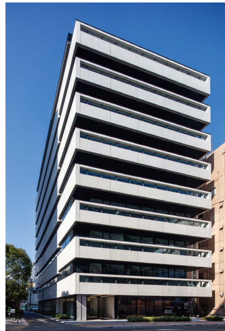
写真1 当ビル外観写真
