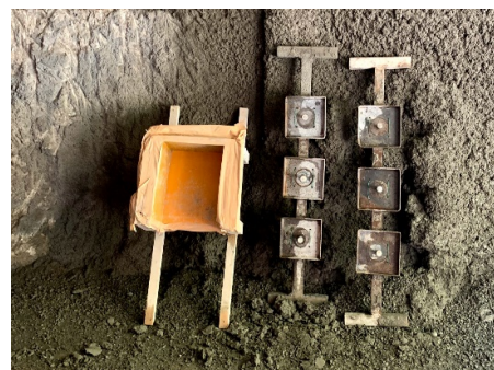
写真 1 強度試験用型枠
