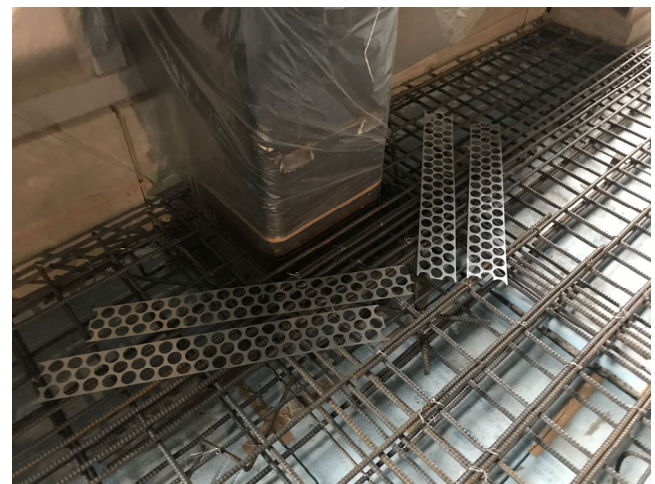
写真 7 柱周辺部への設置状況
