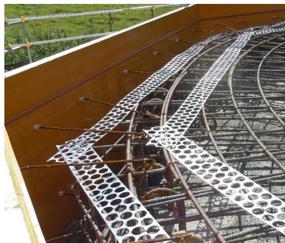
写真4 ハイグリップ・メタルバンド設置状況
