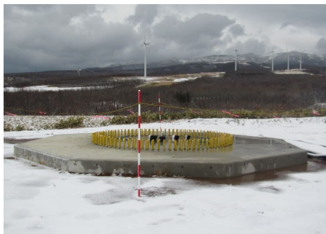
写真5 風車基礎完成状況
