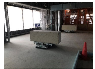
写真 13 14階 (搬送階) 搬送状況
