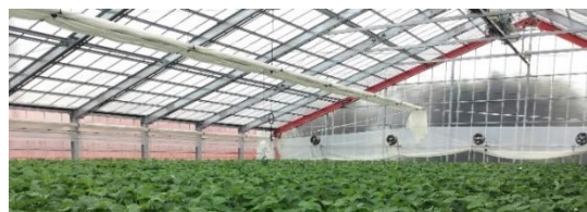
写真2 中柱のない空間
