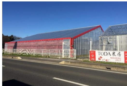
写真1 スリークォータ型屋根が特徴的な高採光型温室の外観
