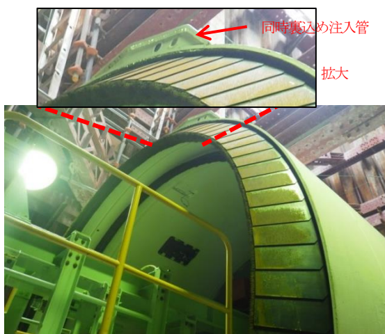
写真9 シールドマシン後方部
