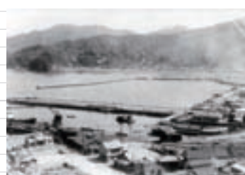
日本製鐵釜石港突堤(1939年)
