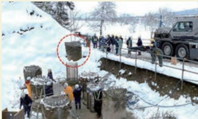
写真1 国交省工事にて監督官・関係者立会いのもと余盛り部の揚重状況(赤丸破線部)
