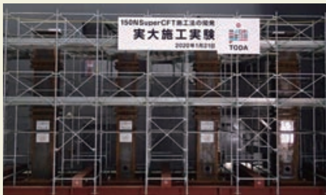
写真1 CFT柱実大試験体
