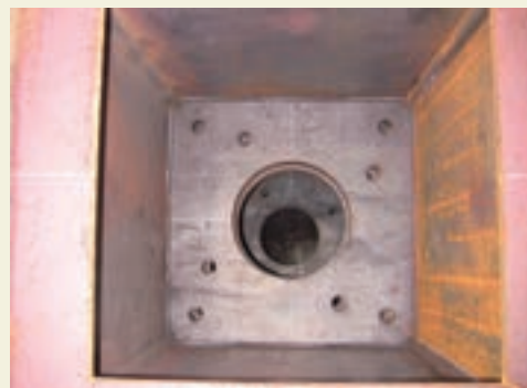
写真3 ダイアフラム形状の例
