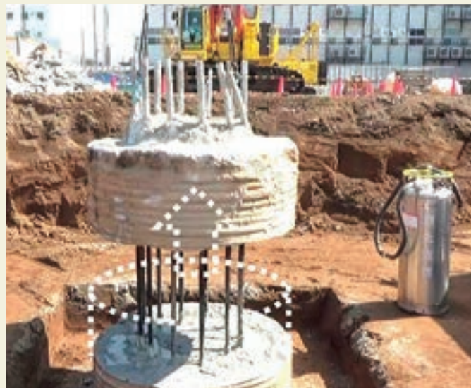
図1 凍結杭頭処理工法の概要図と杭頭余盛り部の引き抜き状況
