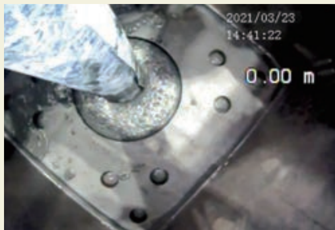
写真2 コンクリート充填状況
