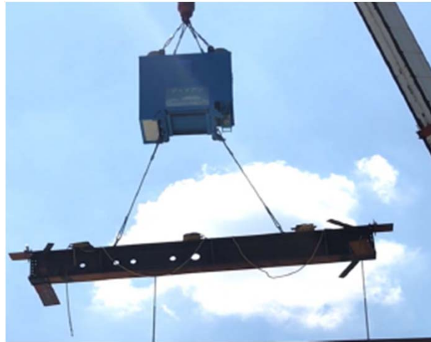
吊荷旋回制御装置の現場適用状況
