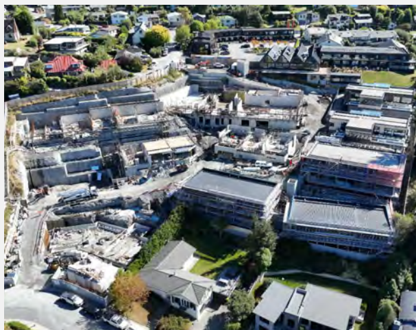
（施工状況：全景写真）
